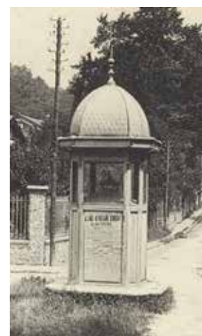
Transformateur d'Ouest Lumière au rond-point de l'avenue de Torcy.
