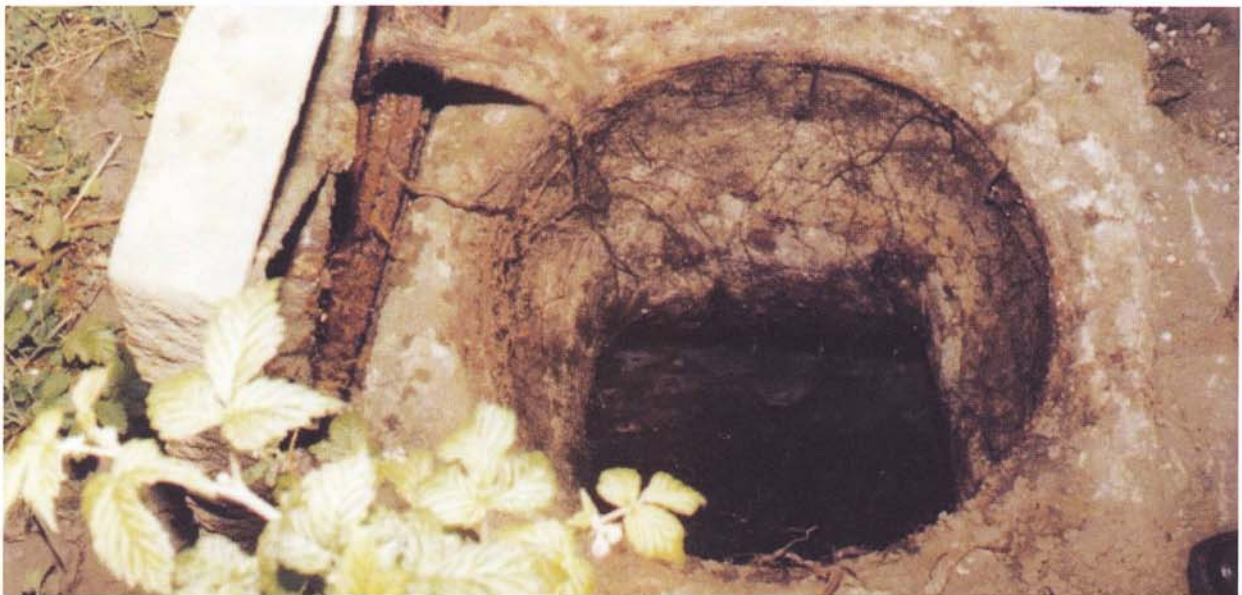
..... fait discrètement son entrée dans Chaville sous l'avenue du Parc.....
