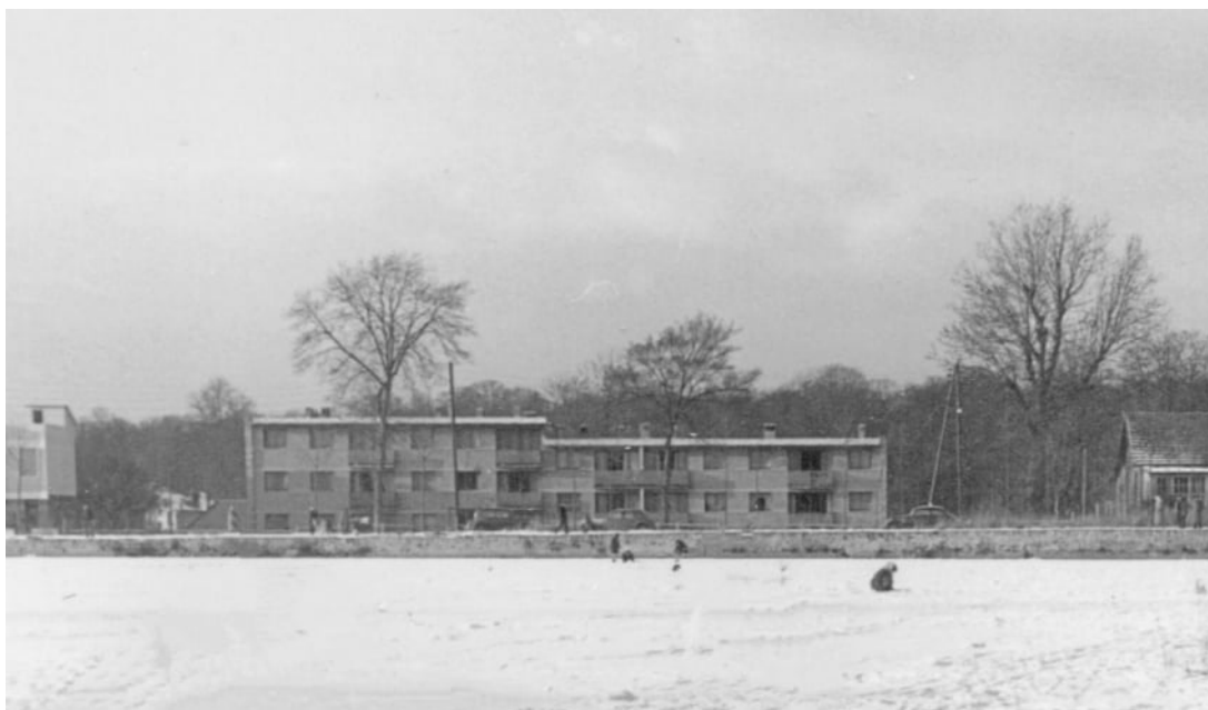
L'immeuble « Vivre » en chantier, route Sablée, hiver 1955, collection particulière.
