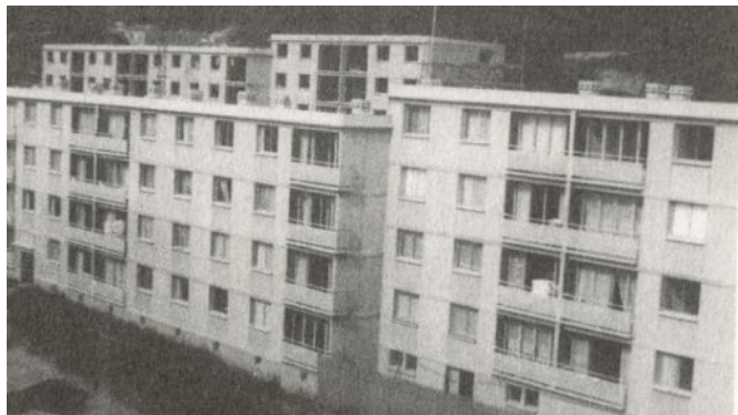
Les immeubles du groupe « Vaincre ».
